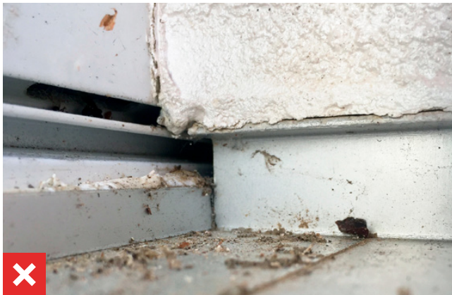
Abb. 26 Gewerke Loch durch offene Nut
