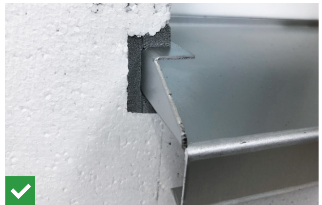
Abb. 37 Rechtwinklig gestossenes Fugendichtungsband
