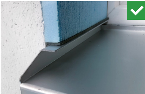
Abb. 46 mit Dämmstoff-Passstück und Fugendichtungsband BG 1
