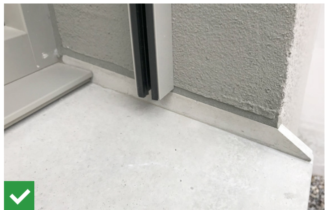
Abb. 12 Putzbordanschluss mit sichtbarem Fugendichtungsband
