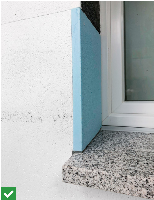
Abb. 23 Steinbank ohne Putzbord mit seitlichem Einstand von 20mm und Fugendichtungsband BG 1 sowie XPS-Passstück
