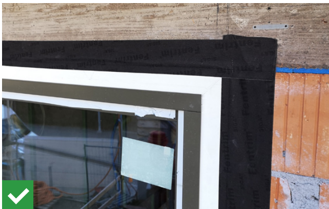
Abb. 29 Winddichtung zwischen Fensterrahmen und Traggrund
