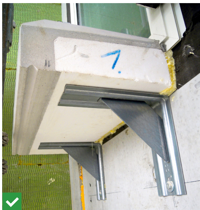
Abb. 5 Einbau einer Glasfaserbeton-Fensterbank auf Stützwinkel
