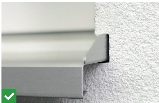
Abb. 51 Starres Stehbord bei Sekundärabdichtung mit seitlichem Einschubprofil
