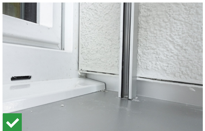
Abb. 13 Putzbordanschluss mit Putzabschlussprofil mit integriertem Fugendichtungsband
