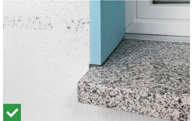
Abb. 54 Exakt eingepasstes XPS-Passstück mit 20mm Fugendichtungsband BG1
