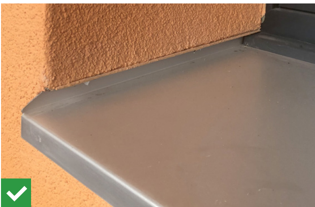
Abb. 41 Funktioneller Trennschnitt
